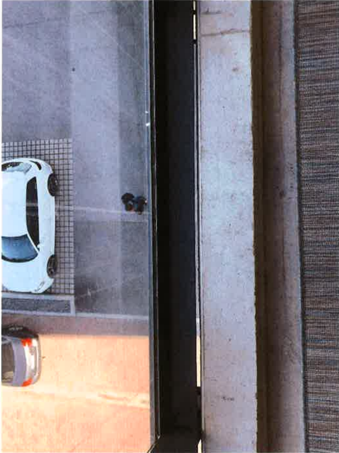
Kuva 3 Parvekelasituksen alareunan rako
